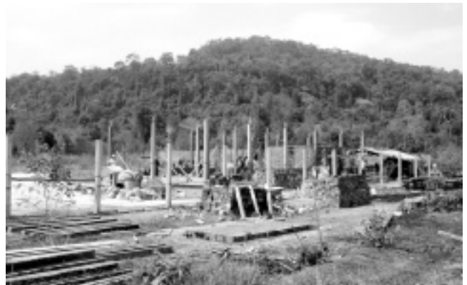
Das Schulungsgebäude des ACCB in Bau, gelegen nördlich von Angkor bei Kbal Spean und mitten im Phnom Kulen Nationalpark.
